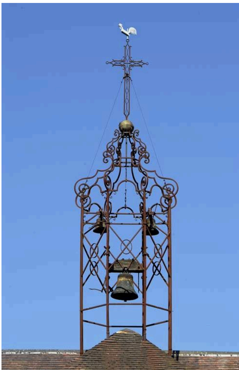
Aile droite : travée de la chapelle, campanile.
