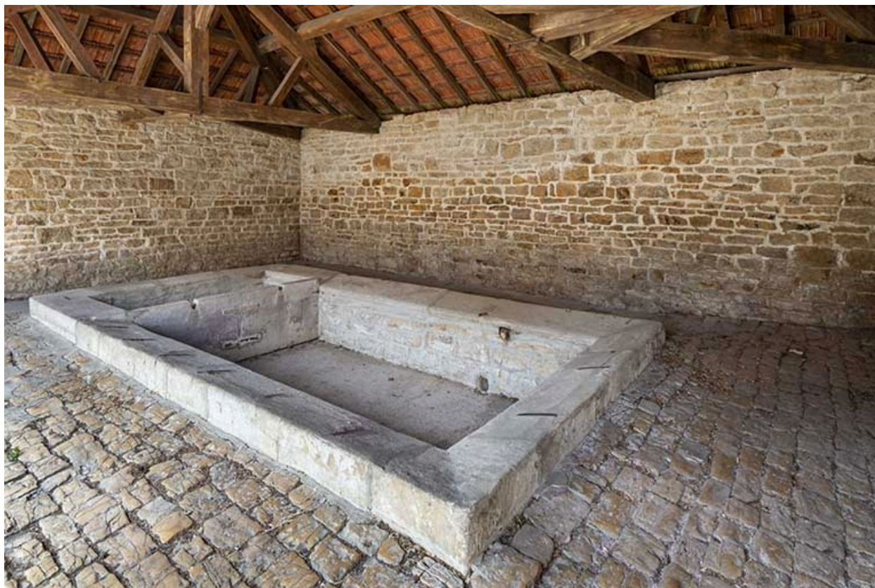
Les deux bassins du lavoir.
