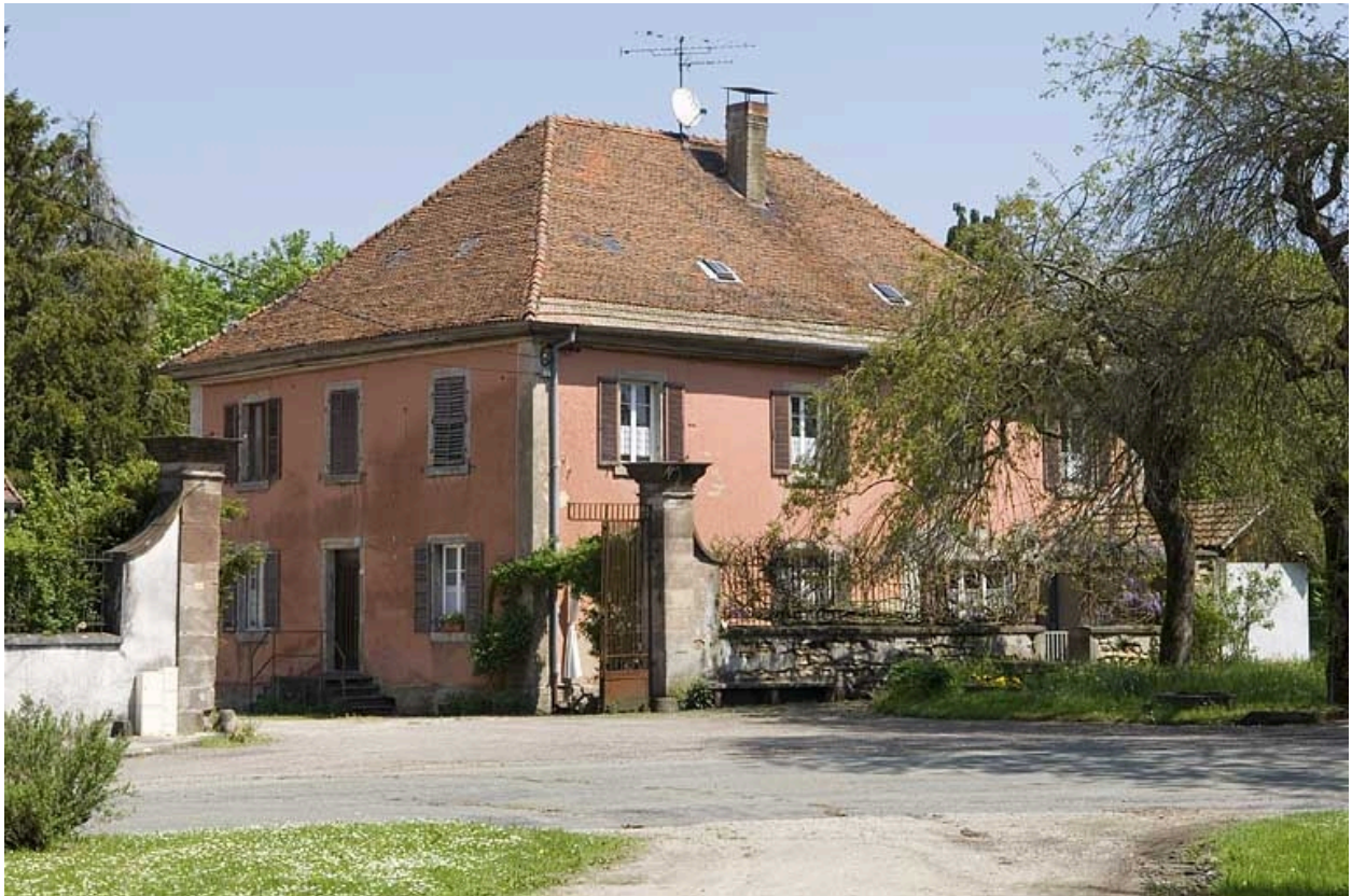
Saline de Gouhenans : bâtiment des bureaux.
