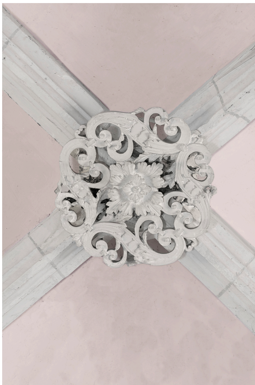
Clef de voûte du chœur.
