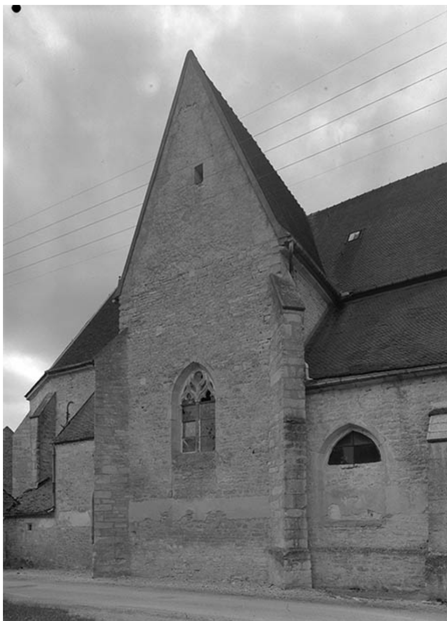
Façade du transept nord.
