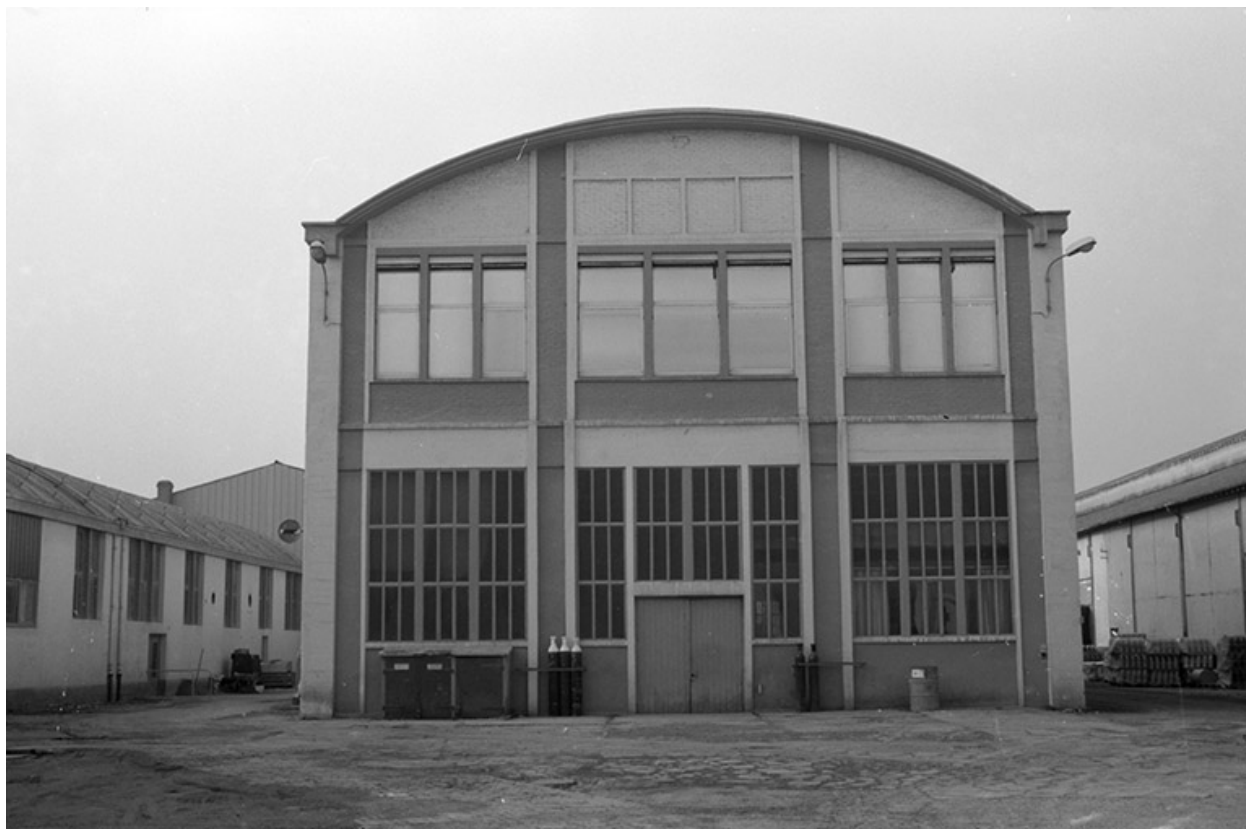
Atelier de réparation (5).
