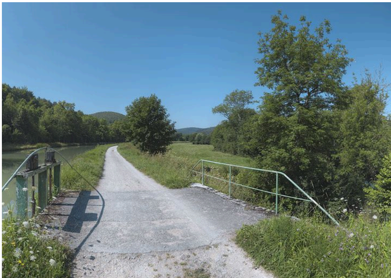
Vannes et garde corps du déversoir.
