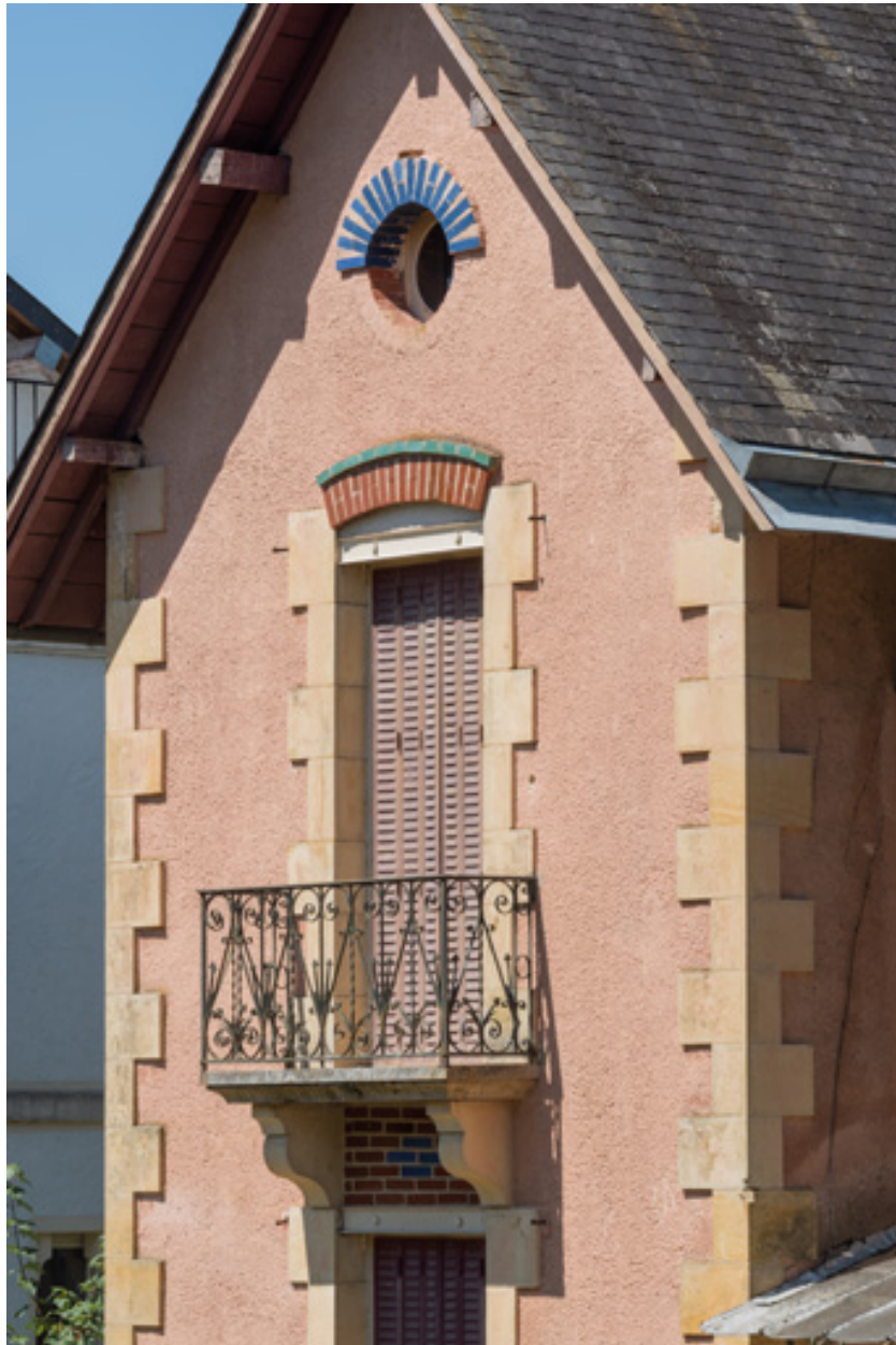
Mur-pignon, détail des ouvertures, vue de trois-quarts.
