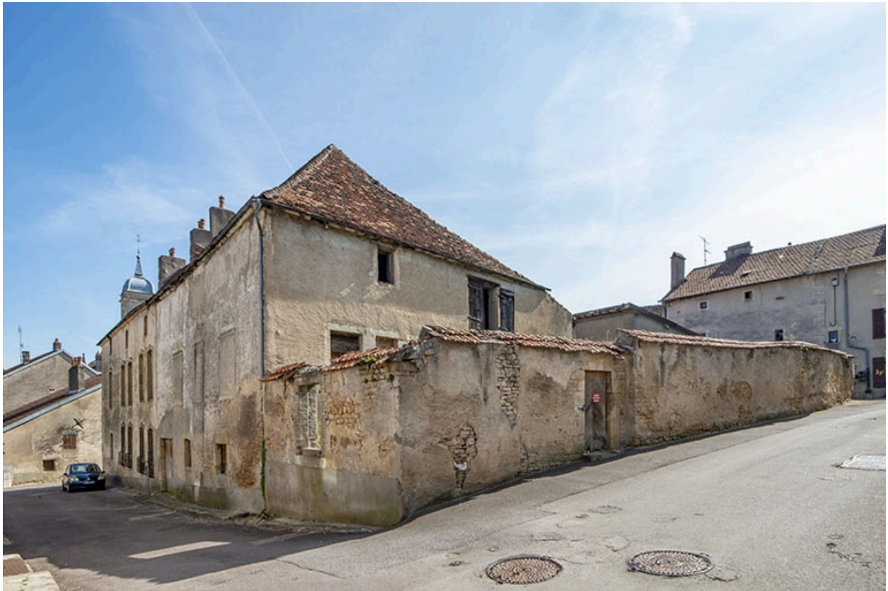
Angle nord-ouest de la maison, à l'angle des rues Patet-Traverse et Général-Etienne.
