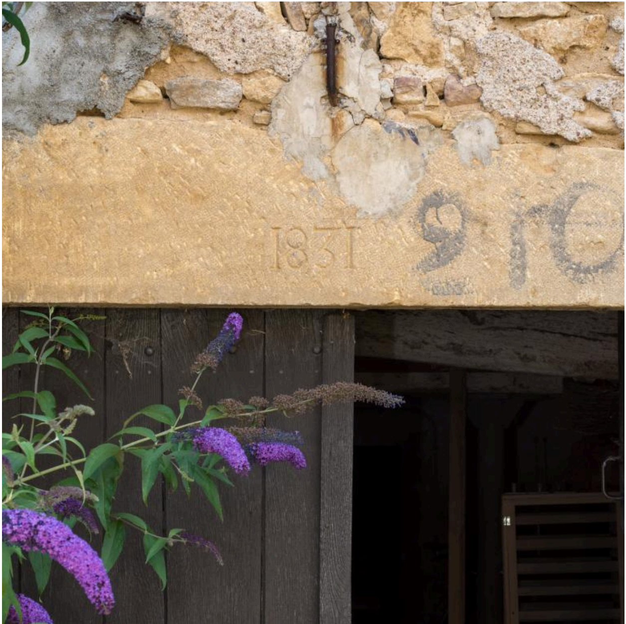
Détail du linteau d'une des portes d'étables portant la date de 1831
