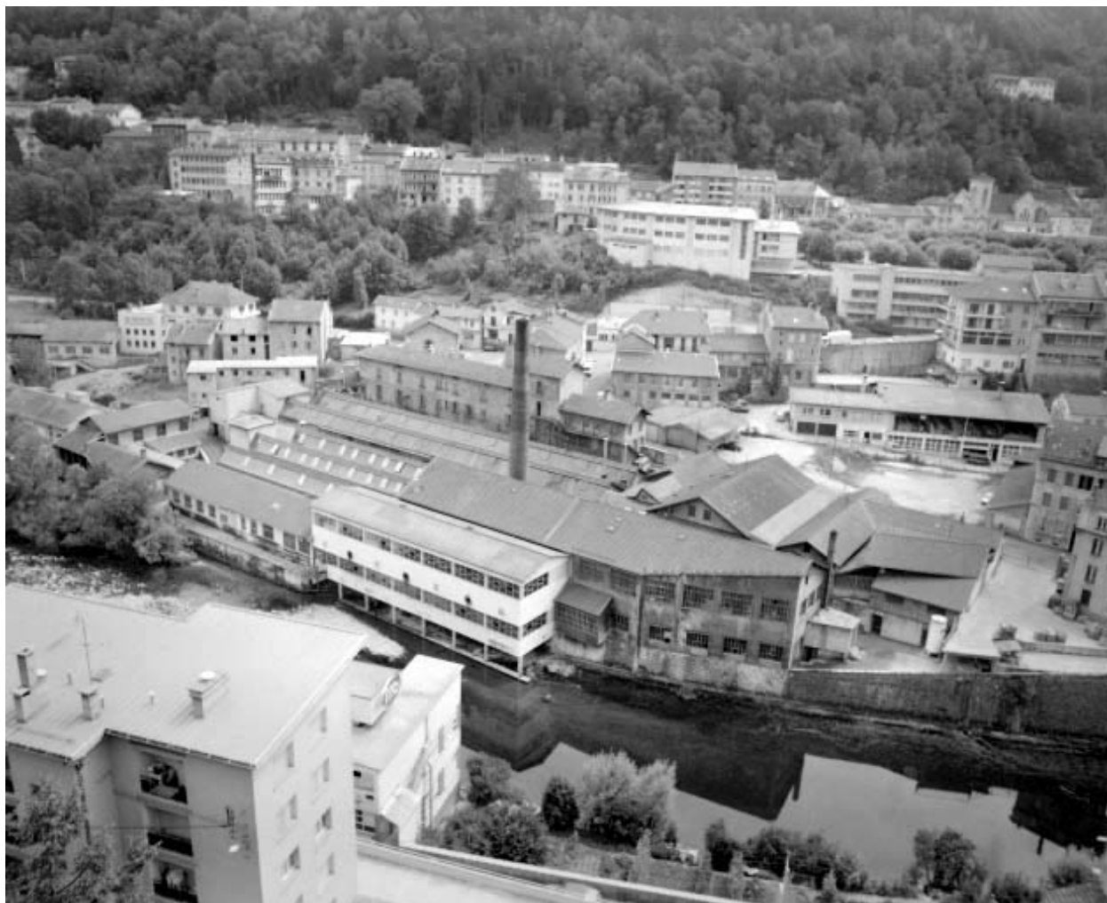
Vue d'ensemble plongeante depuis le nord-ouest.
