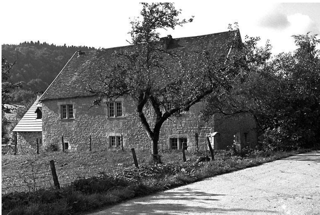
Façade postérieure vue depuis le chemin.
