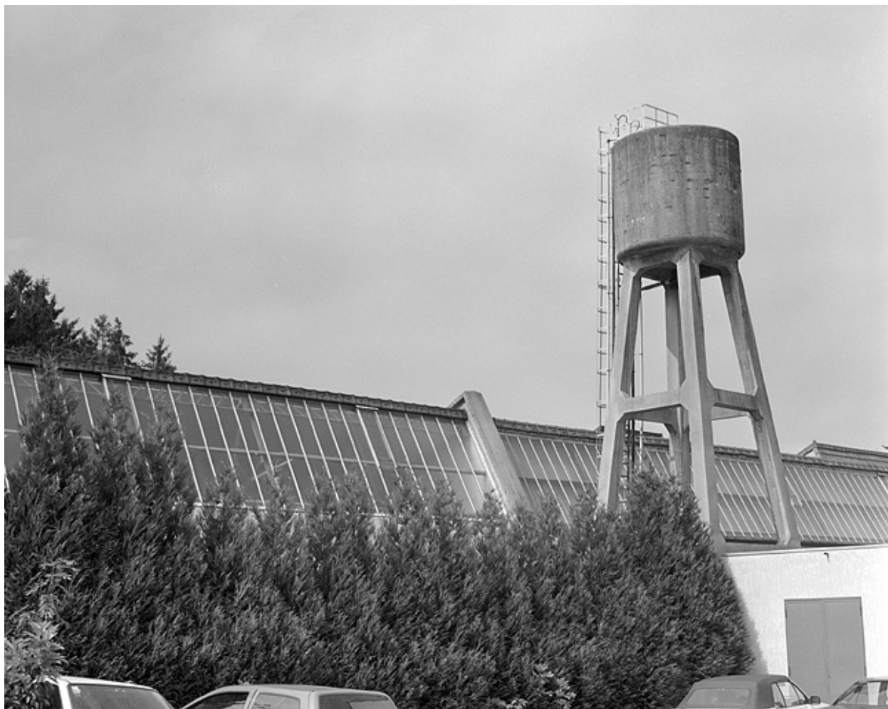
Atelier de fabrication et réservoir industriel.
