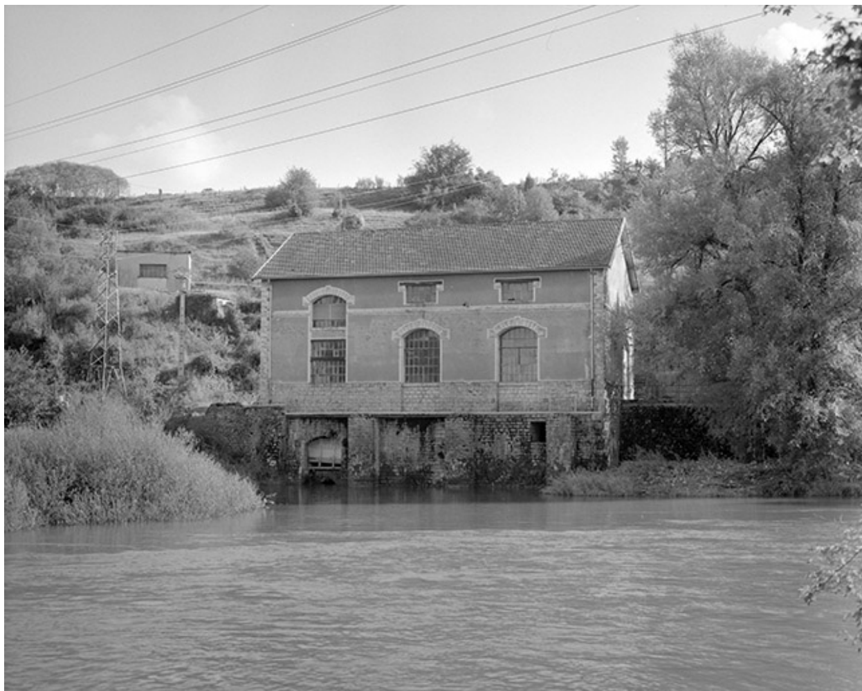
Façade postérieure de la centrale.
