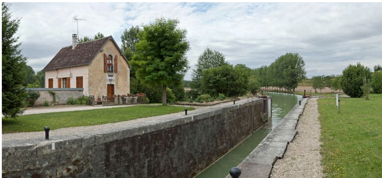
Vue d'ensemble du site d'écluse.
