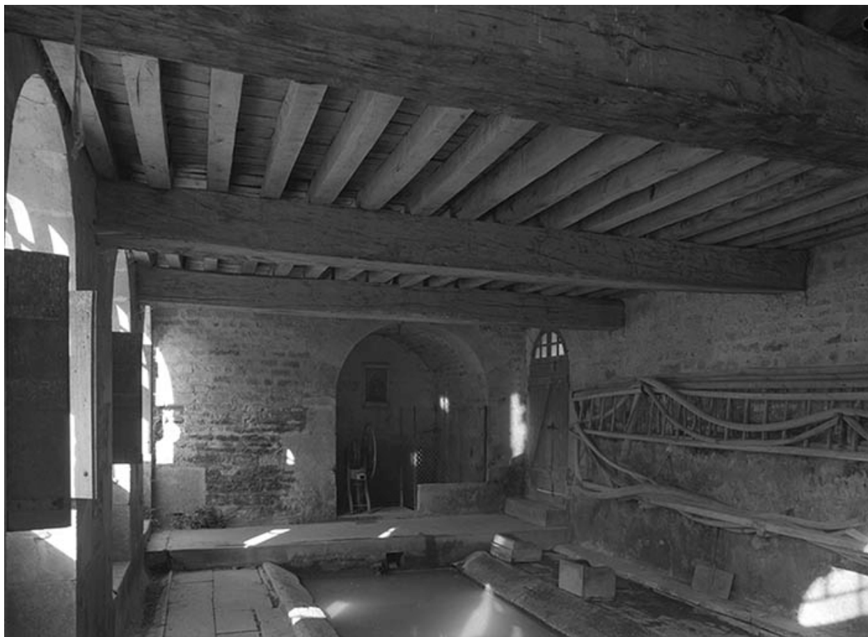
Vue intérieure. Lavoir.
