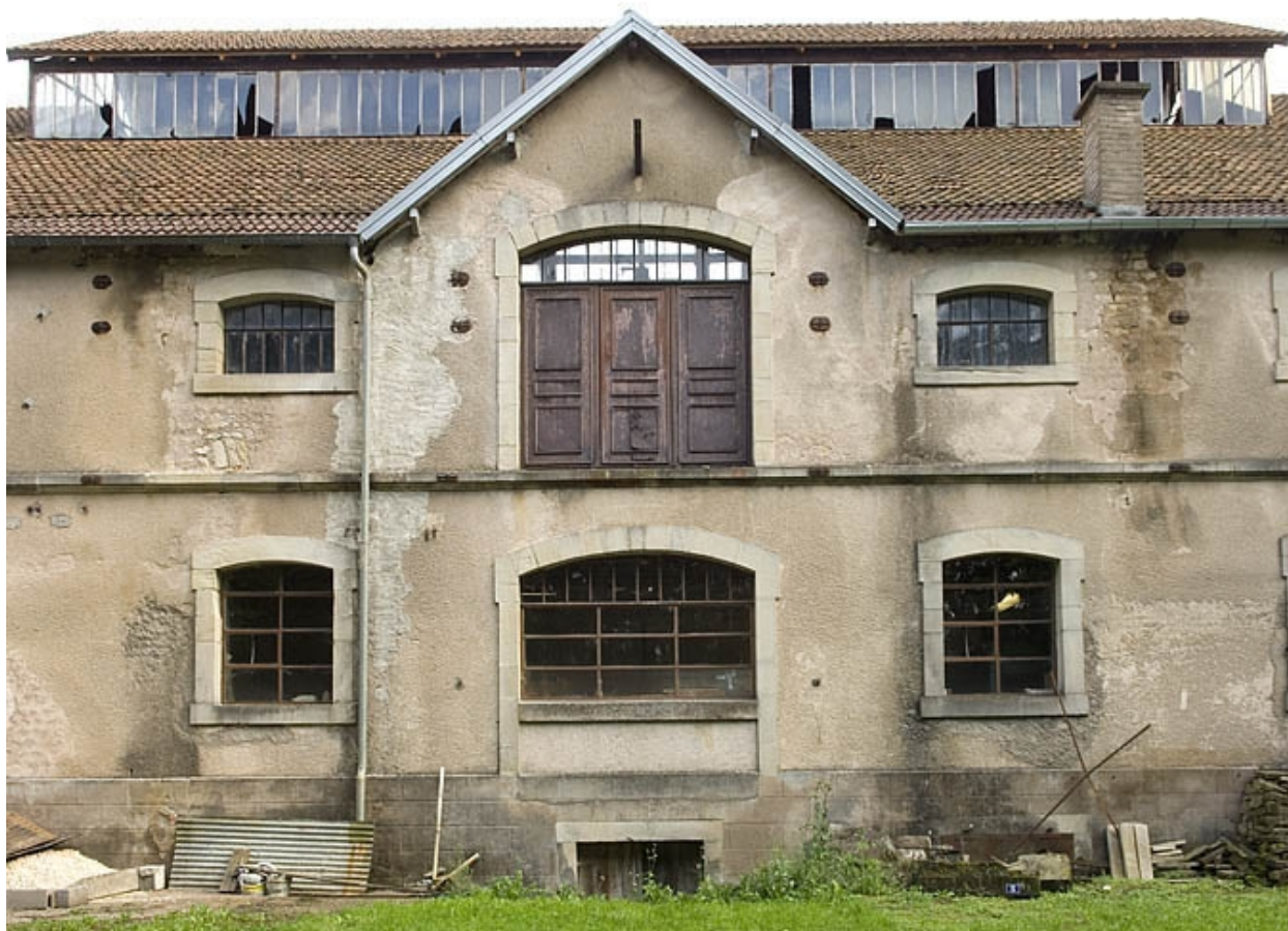
Travée centrale de la façade postérieure.
