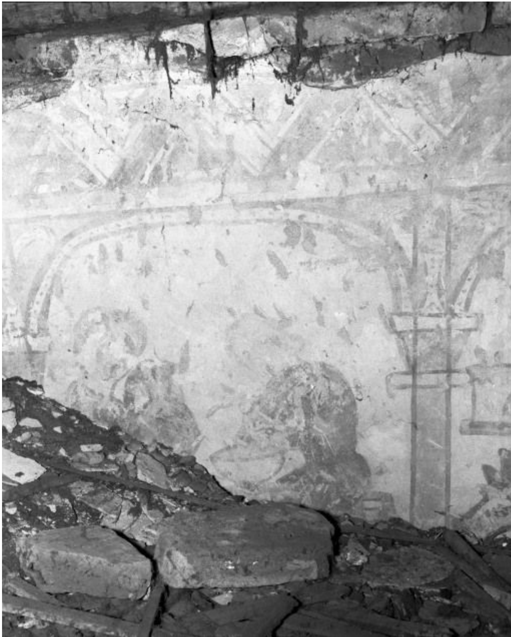
Comble de la nef, mur droit
