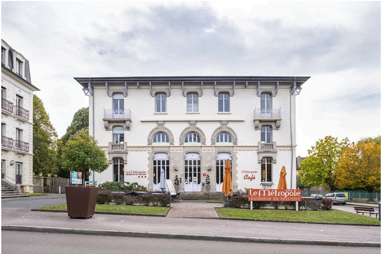
Façade nord, vue de face.
