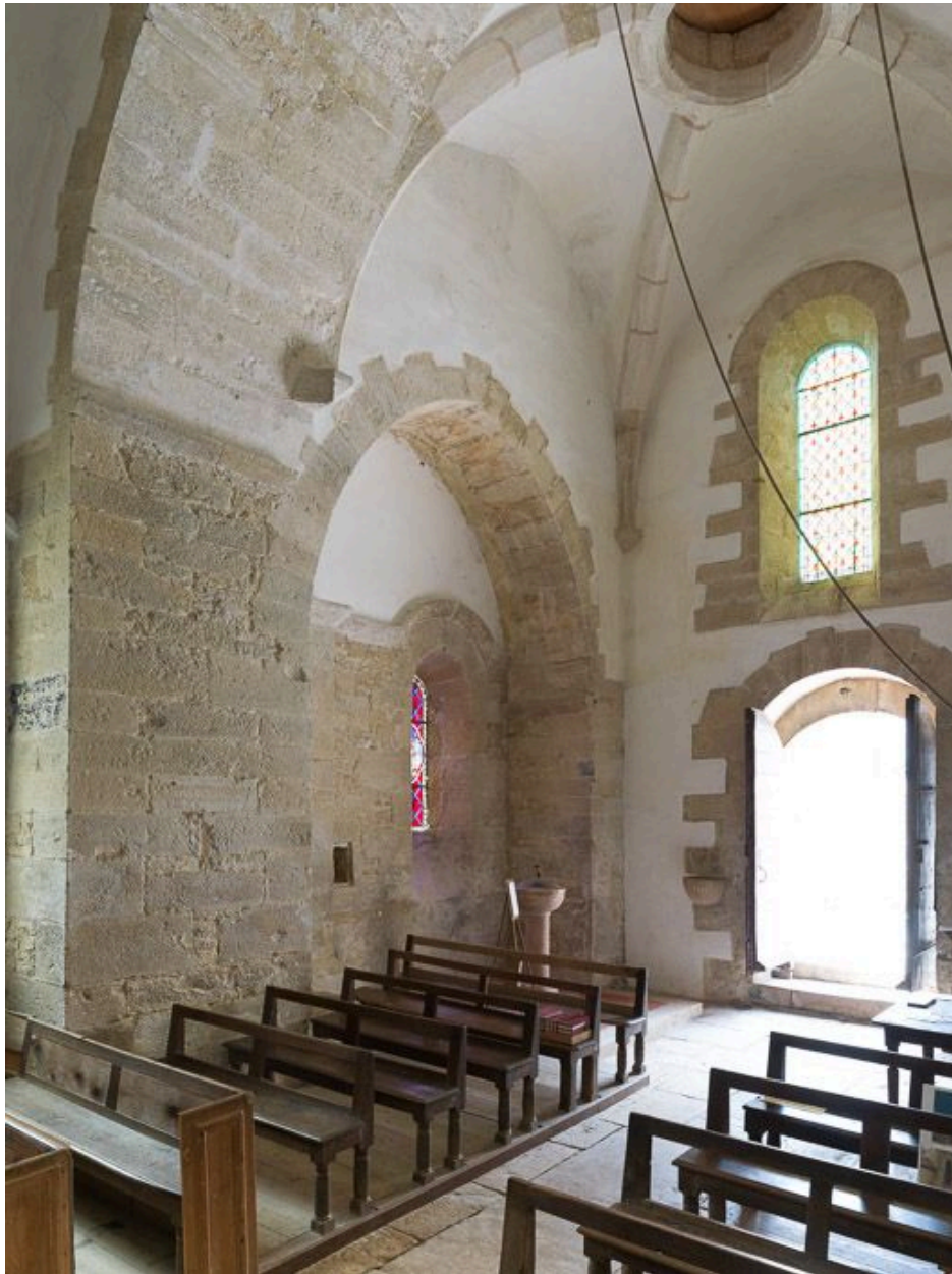
La travée sous clocher : vue de trois quarts.
