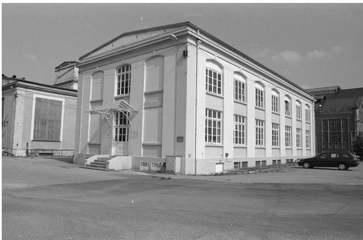
Bureaux généraux, vus de l'ouest.
