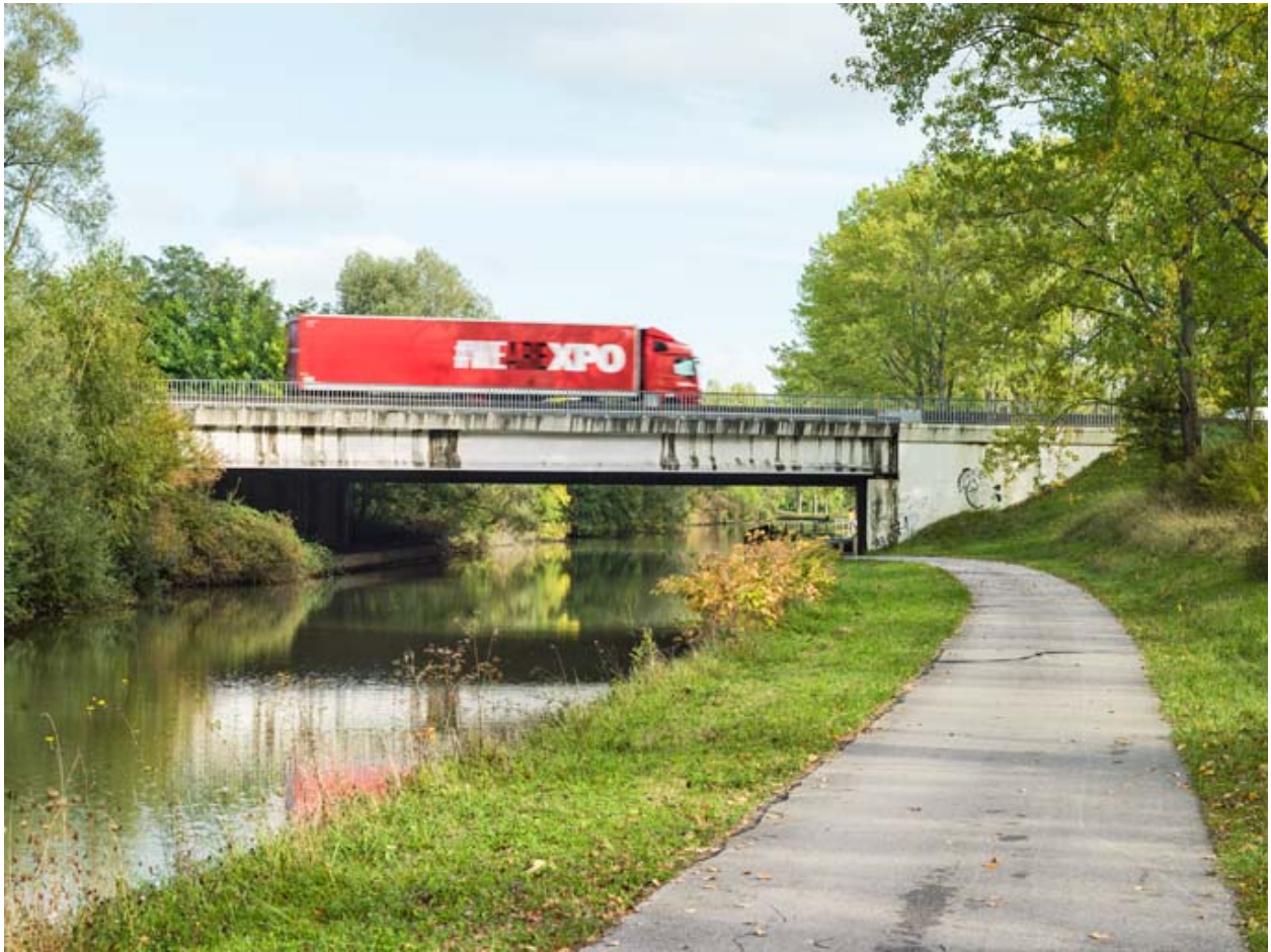
Vue d'ensemble du pont.
