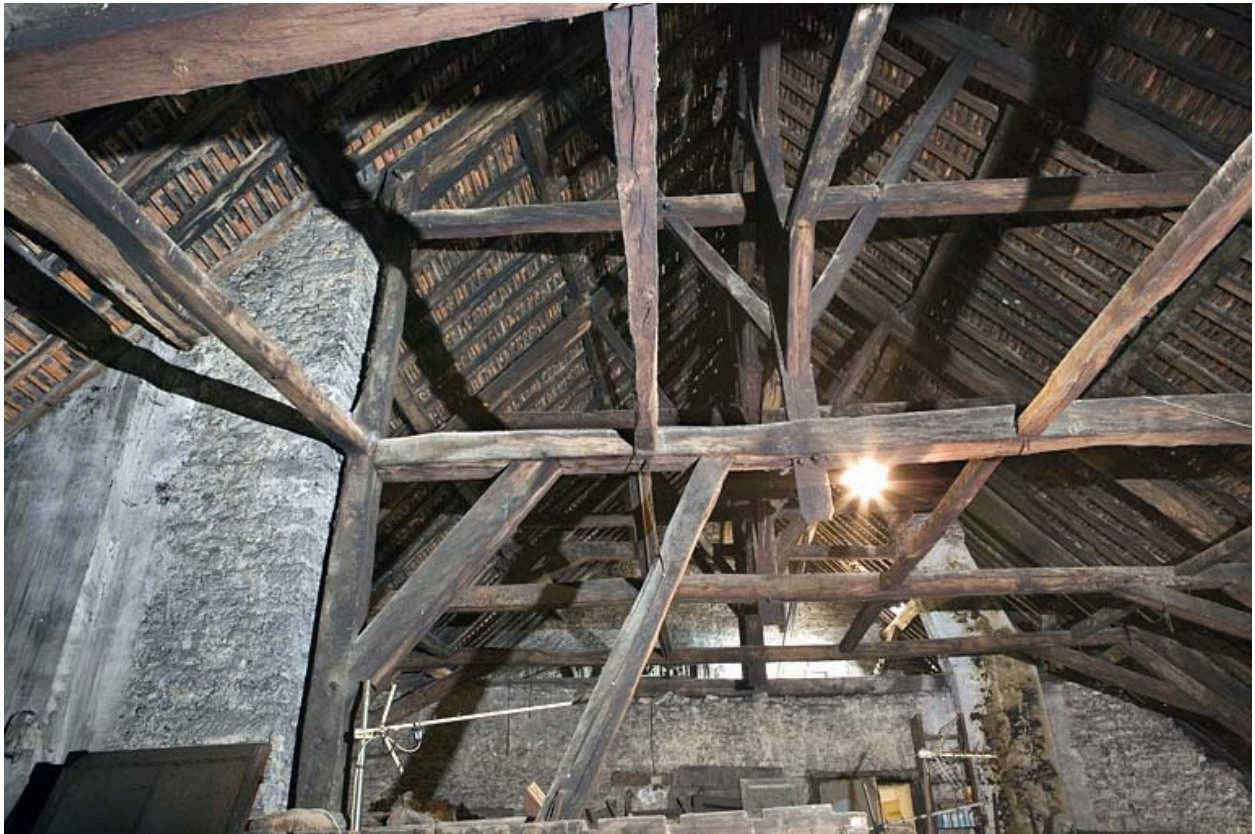
Intérieur, comble : vue d'ensemble de la charpente depuis le fond du grenier.
