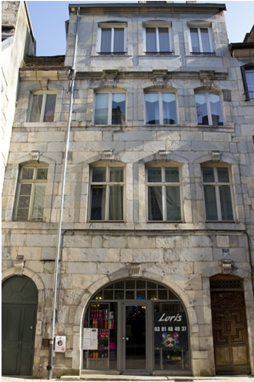
Vue d'ensemble de la façade antérieure.
