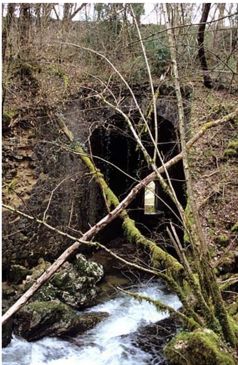
Pont sur le Lizon, depuis l'amont (nord).
