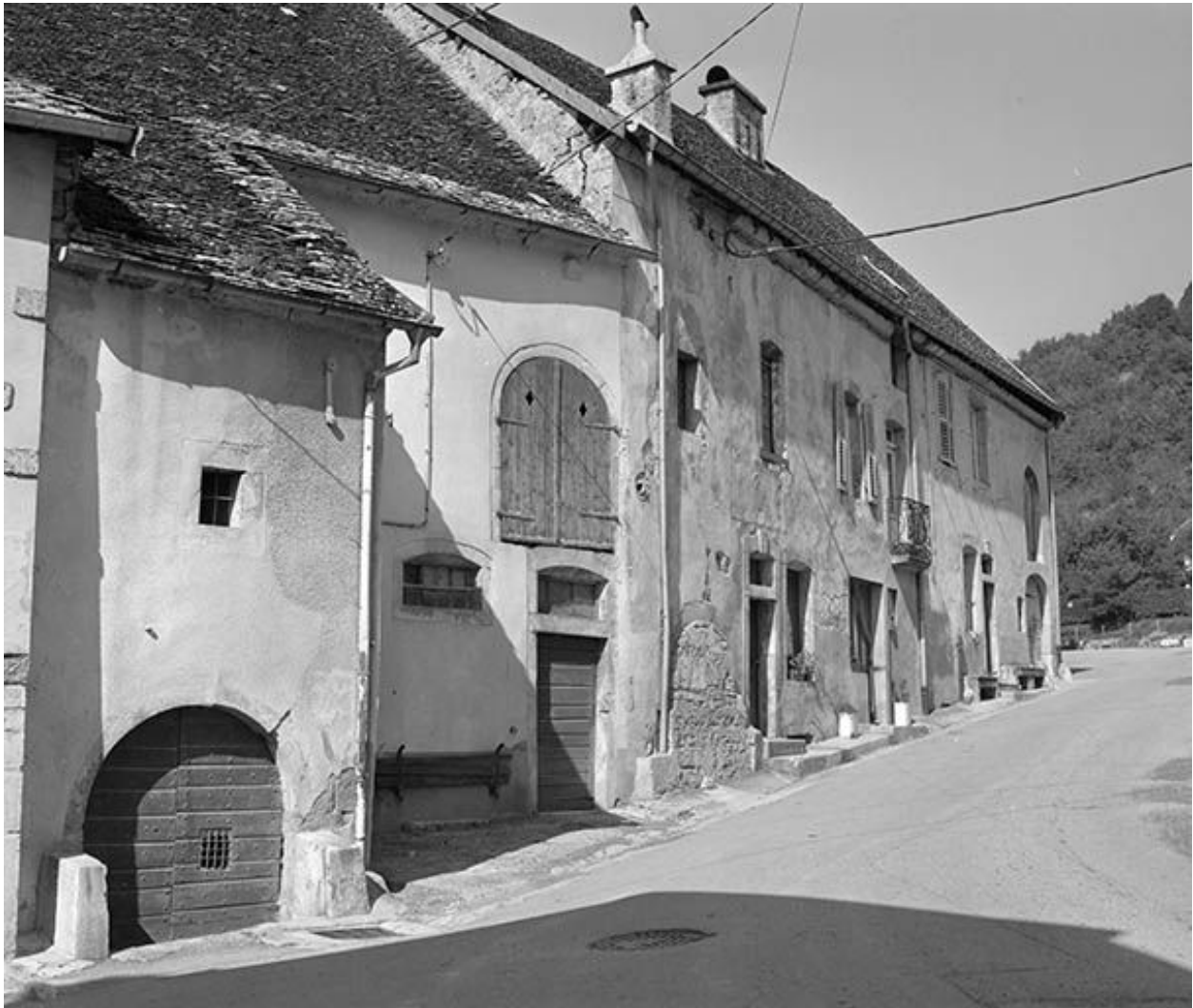
Maisons situées rue du Chapité, cadastrées 1971 AB 322 à 324.
