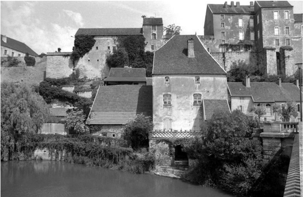
Vue du village depuis le pont route de Dole.
