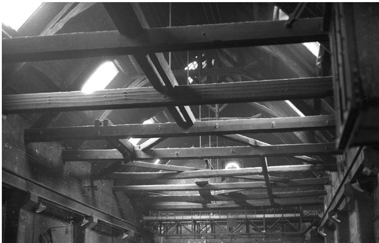
Charpente d'un atelier de fabrication.
