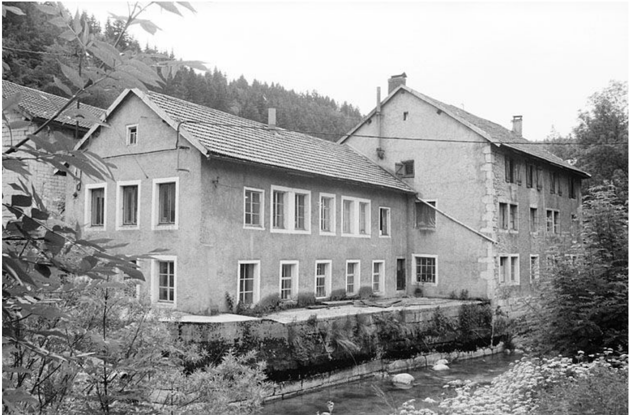
Ancienne clouterie : façades sur la Bienne.
