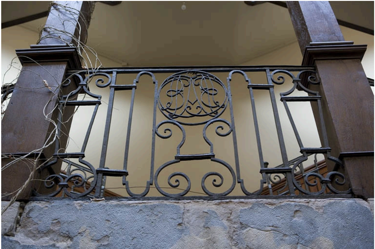
Détail de la ferronnerie de l'escalier à cage ouverte.
