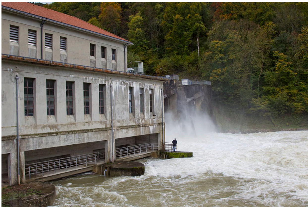
Centrale hydroélectrique de Vaufrey, en période de crue.
