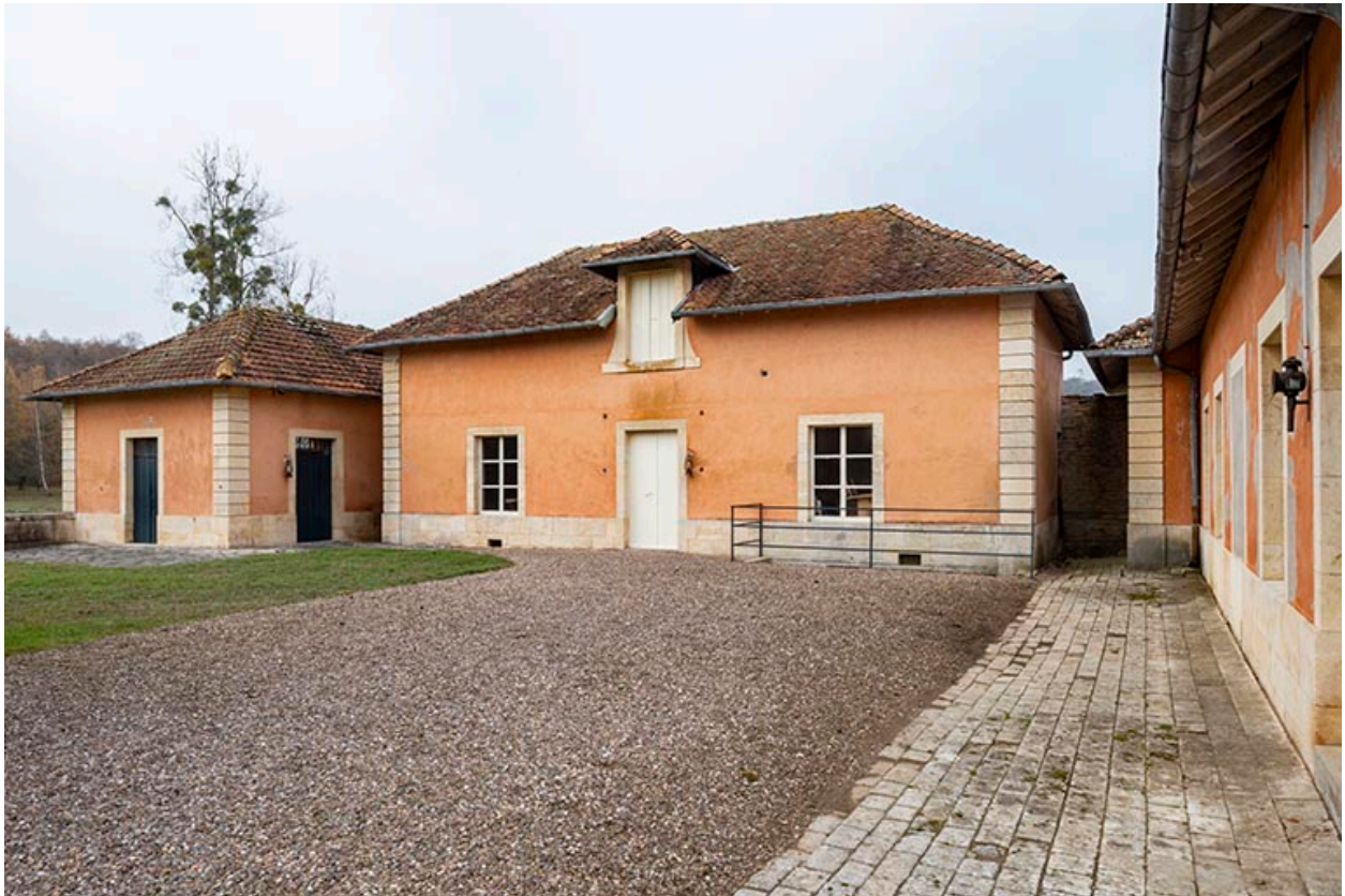
Bâtiments des dépendances du côté nord de la cour.
