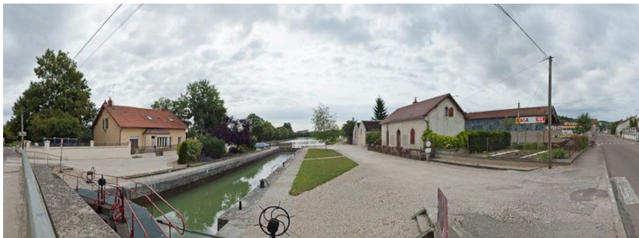
Vue d'ensemble du site d'écluse.
