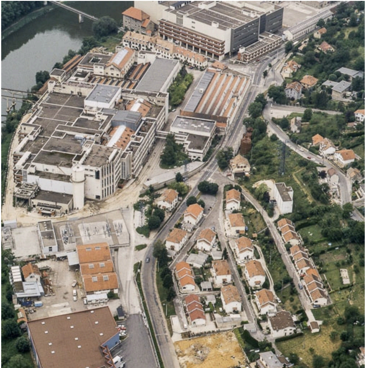
Vue aérienne de l'usine A et de la cité ouvrière, depuis l'est.
