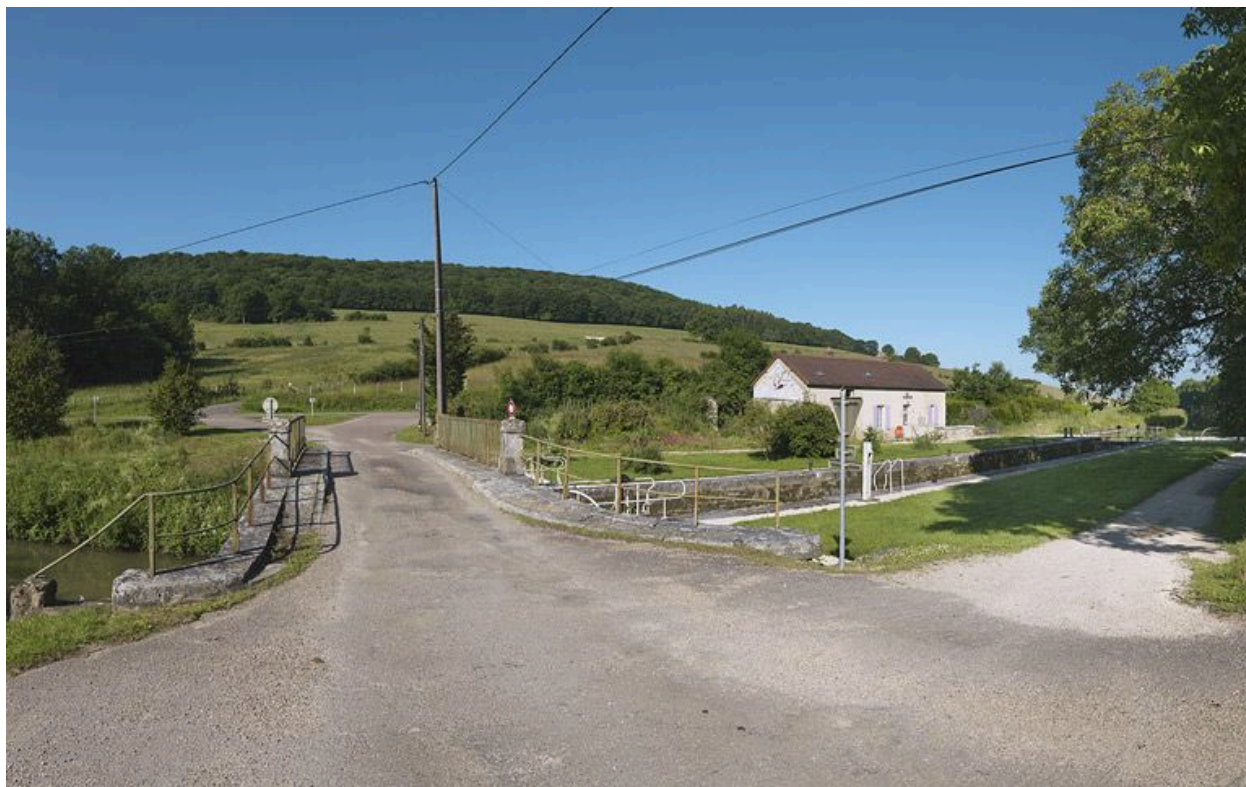
Site d'écluse vu d'aval.
