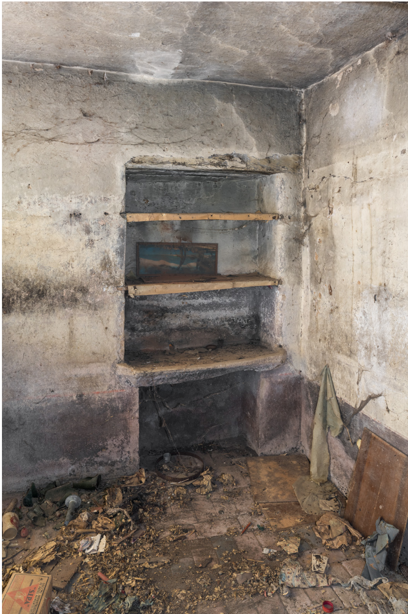
Niche et pierre d'évier dans la pièce du rez-de-chaussée.
