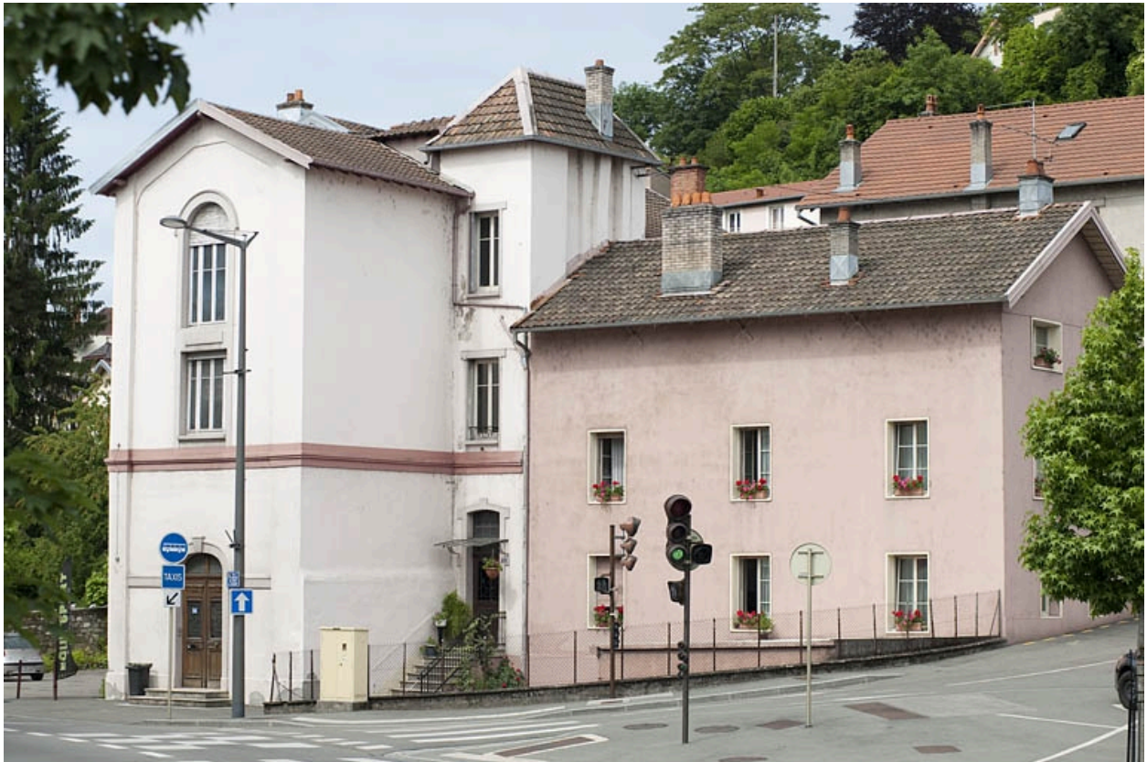
Bâtiments administratifs (?). Vue depuis le sud-est.
