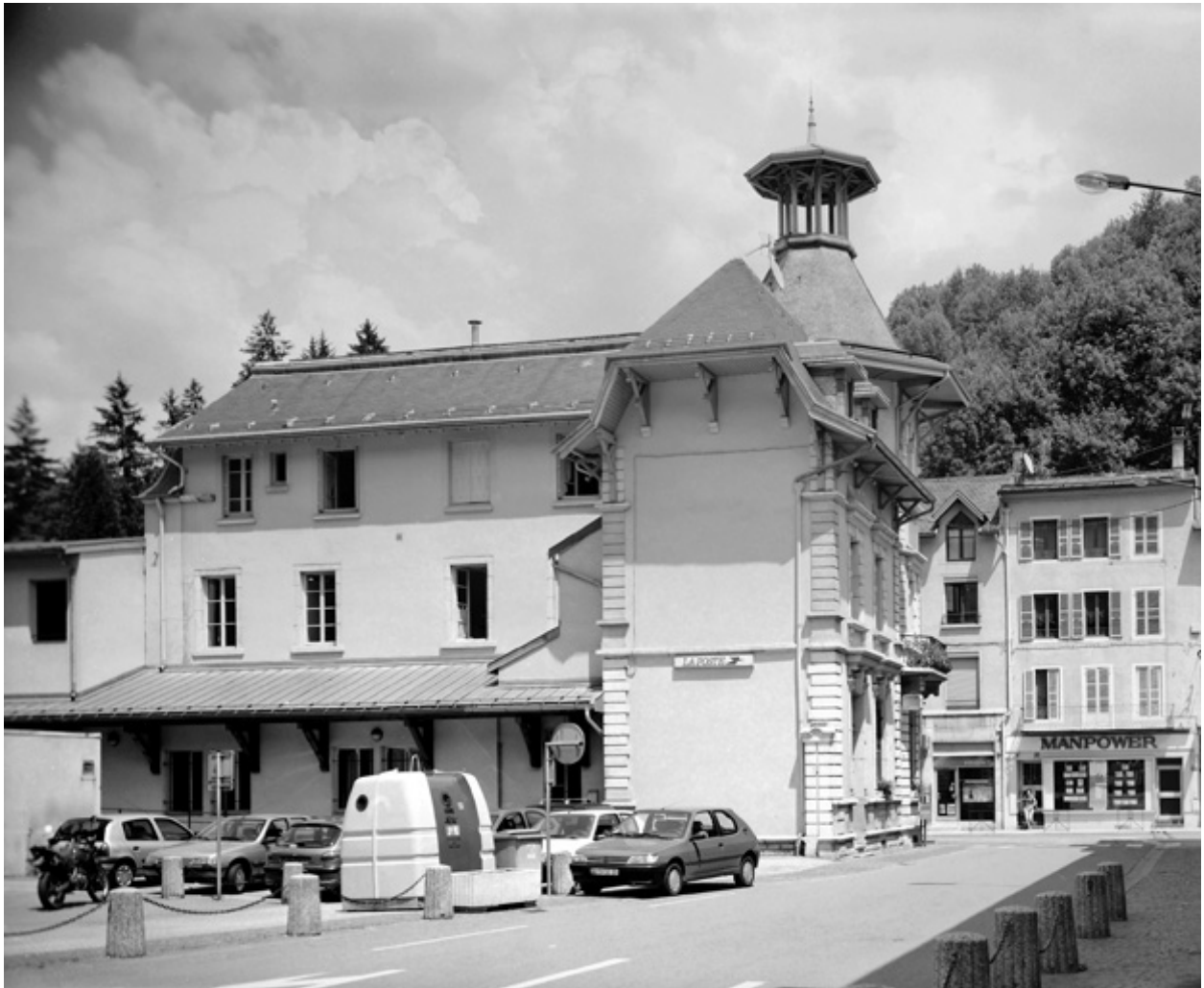
Façade postérieure, depuis la rue Lamartine (sud-ouest).
