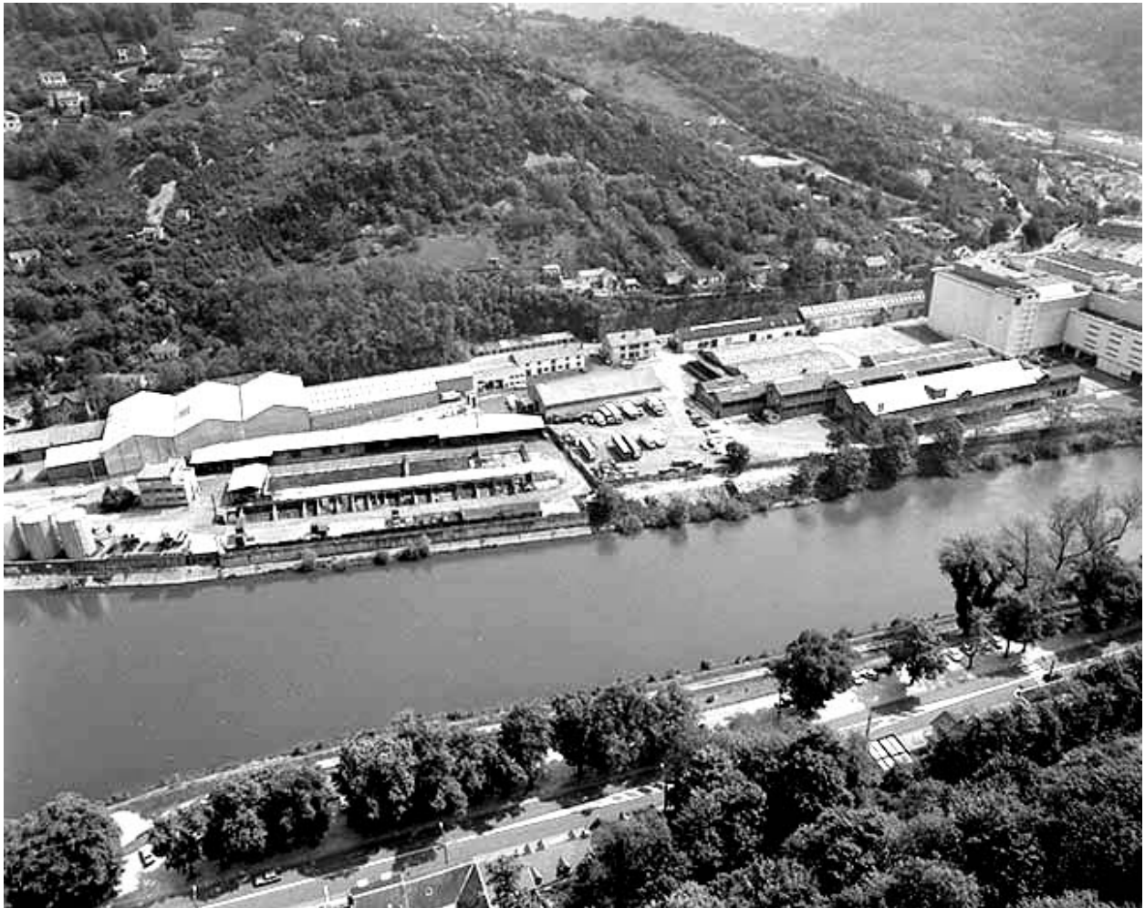
Vue d'ensemble de l'usine B depuis l'ouest : extrémité nord.
