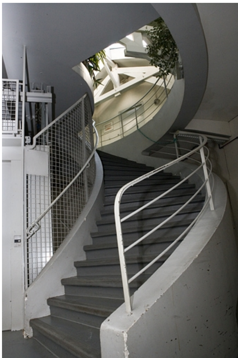
Volée d'escalier du quatrième étage.
