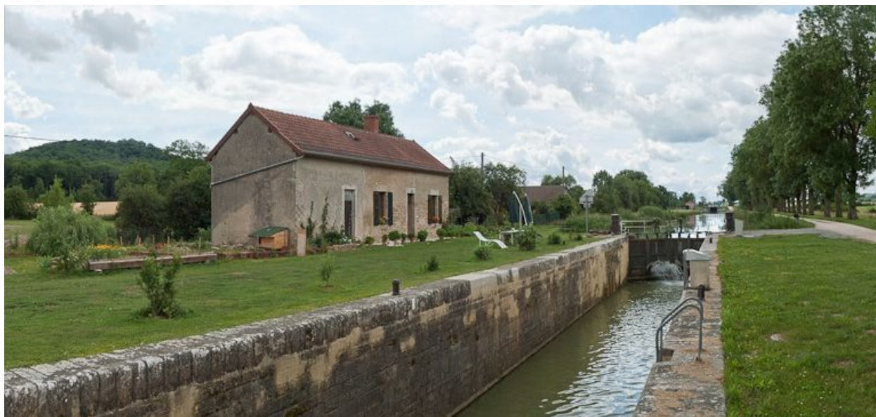
Vue d'ensemble du site d'écluse.
