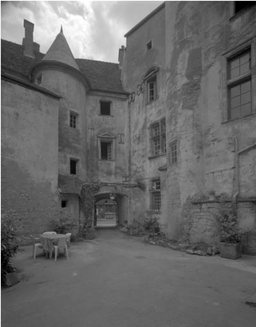
Bâtiment droit : vue du passage couvert depuis le fond de la cour intérieure.
