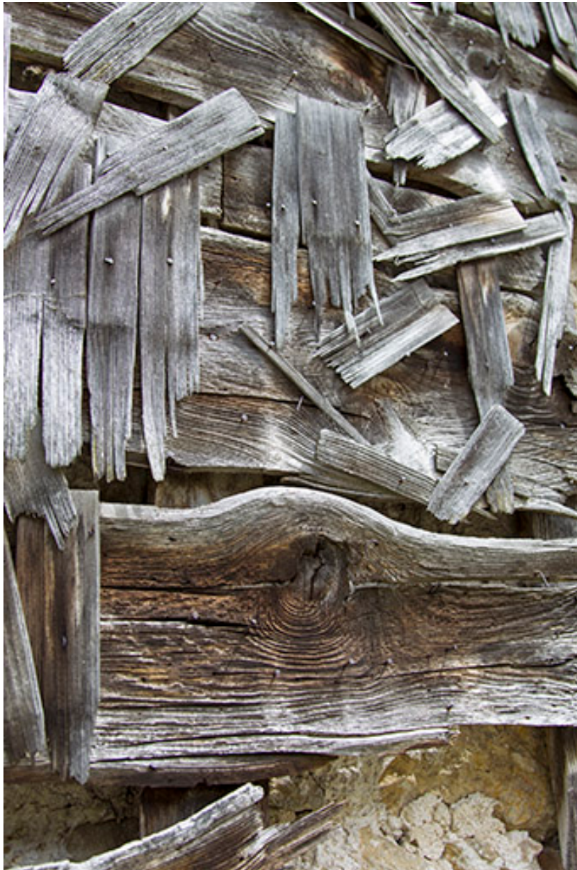
Façade postérieure : support de l'essentage de tavillons, avec quelques tavillons.
