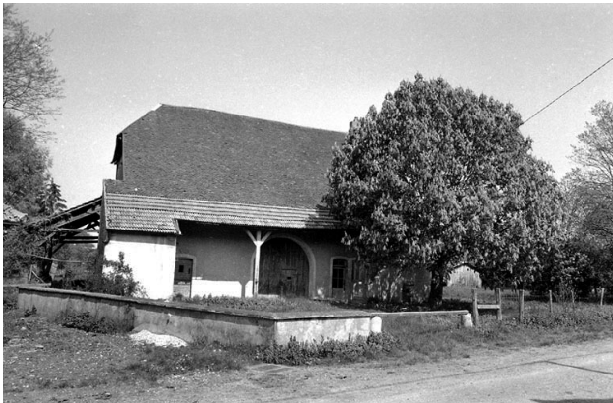
Vue d'ensemble depuis la rue.
