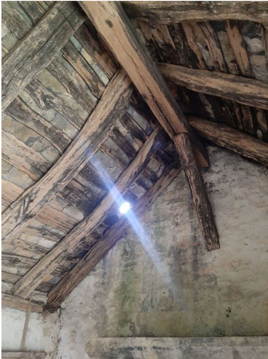
Détails de la charpente de la cabane.
