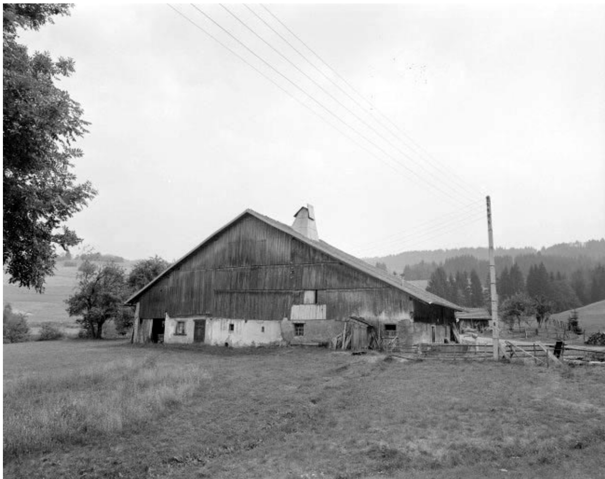
Ferme située au lieu-dit La Grand'Raie, cadastrée AB 89 : façade postérieure.
