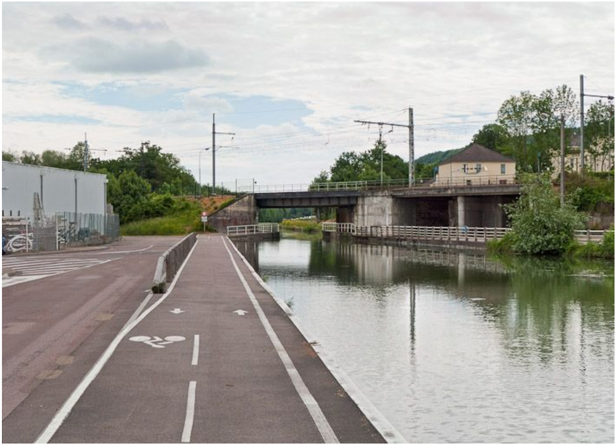
Vue d'ensemble du pont.
