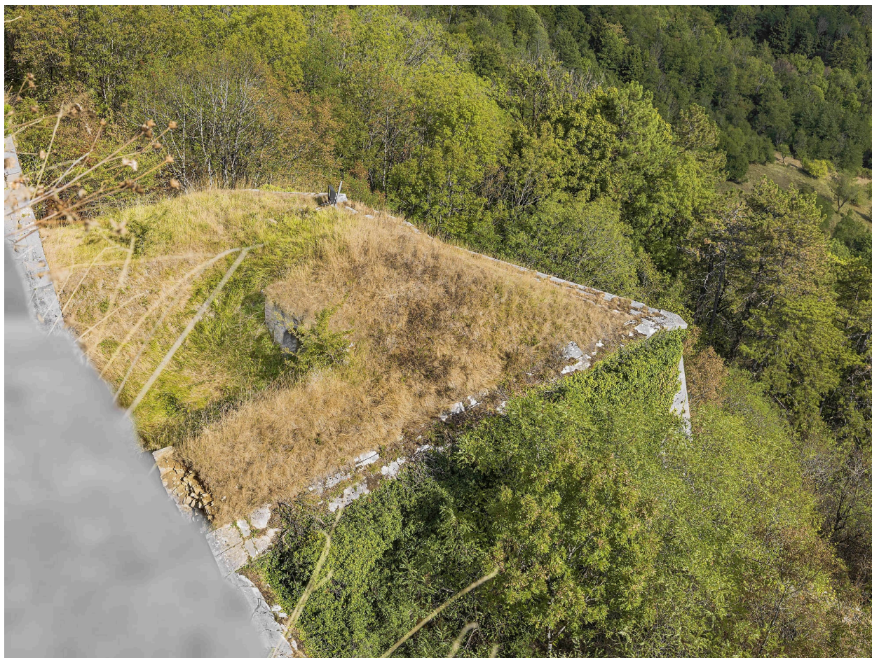
Demi-bastion de l'ouvrage à cornes.
