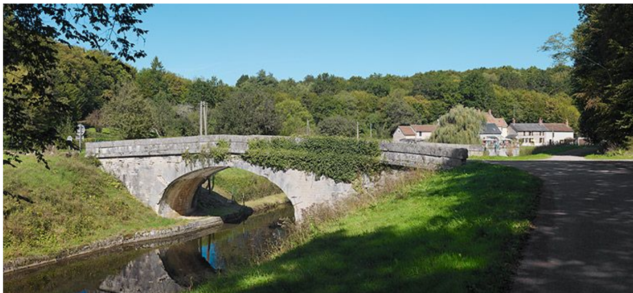
Vue d'ensemble du pont.
