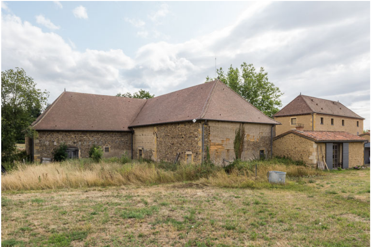
Vue d'ensemble des bâtiments au nord-est
